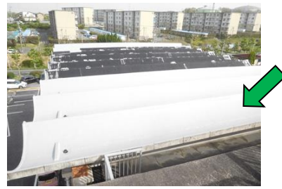
賃貸店舗 屋上防水
