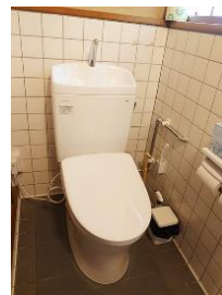
トイレ洋式化、洗浄機付便器 （泗翠庵）
