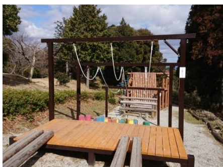
アスレチック遊具修繕 (綱渡りロープ)
