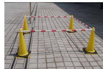
中庭の床タイルの修繕 (文化会館)
