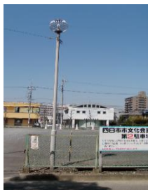
第2駐車場照明 LED 化 （文化会館）
